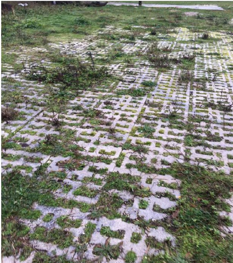
Foto – Pavimentazione esistente zona Box prefabbricati
