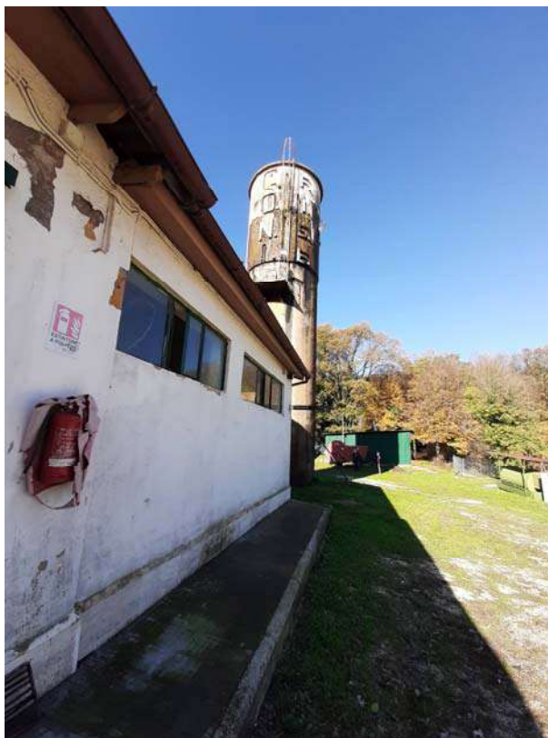
Foto 9/10 – Torre piezometrica e Mascalcia
