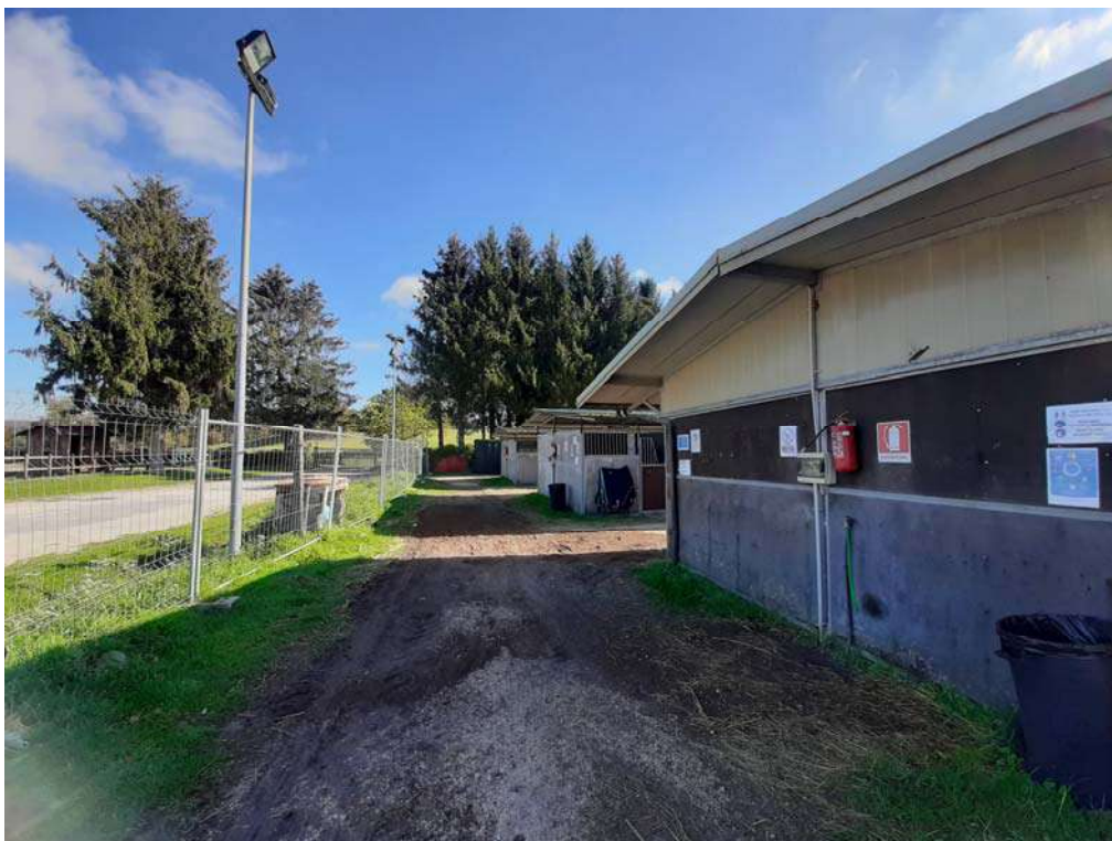
Foto 23 – Box cavalli per eventi (manufatti leggeri prefabbricati amovibili)
