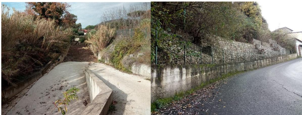
*Figura 12– Interventi di riduzione del rischio: nell'immagine a destra le gabbionate in località San Sebastiano; a sinistra la vasca di raccolta in località Pentima Stalla.*
