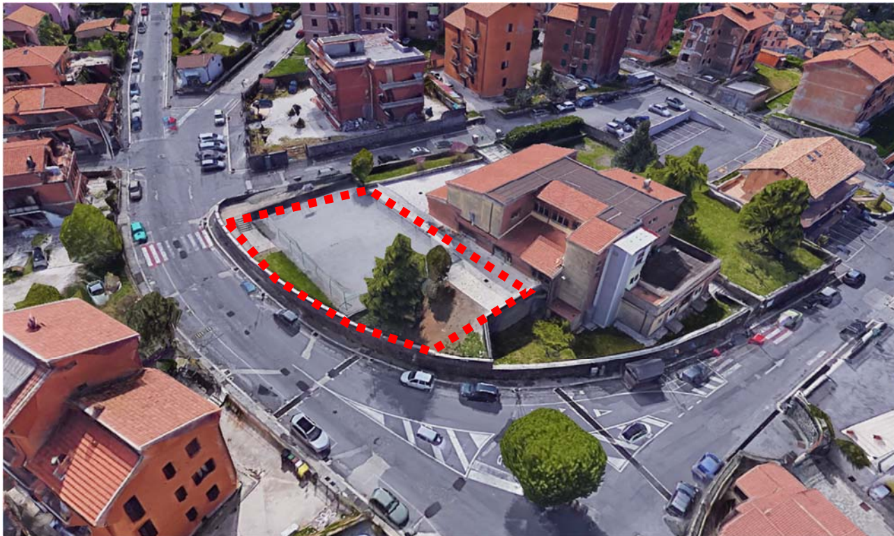
Vista della scuola da nord – in evidenza il lotto dove verrà realizzata la palestra interrata
