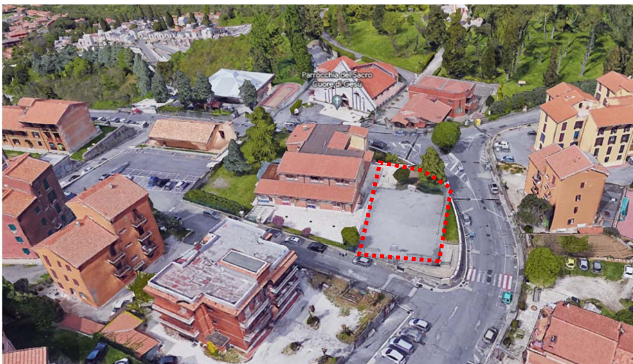
Vista della scuola da sud – in evidenza il lotto dove verrà realizzata la palestra interrata
