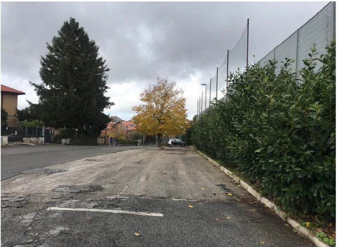
Vista del parcheggio a via Monte Pennolo, sulla destra il campo a 11
