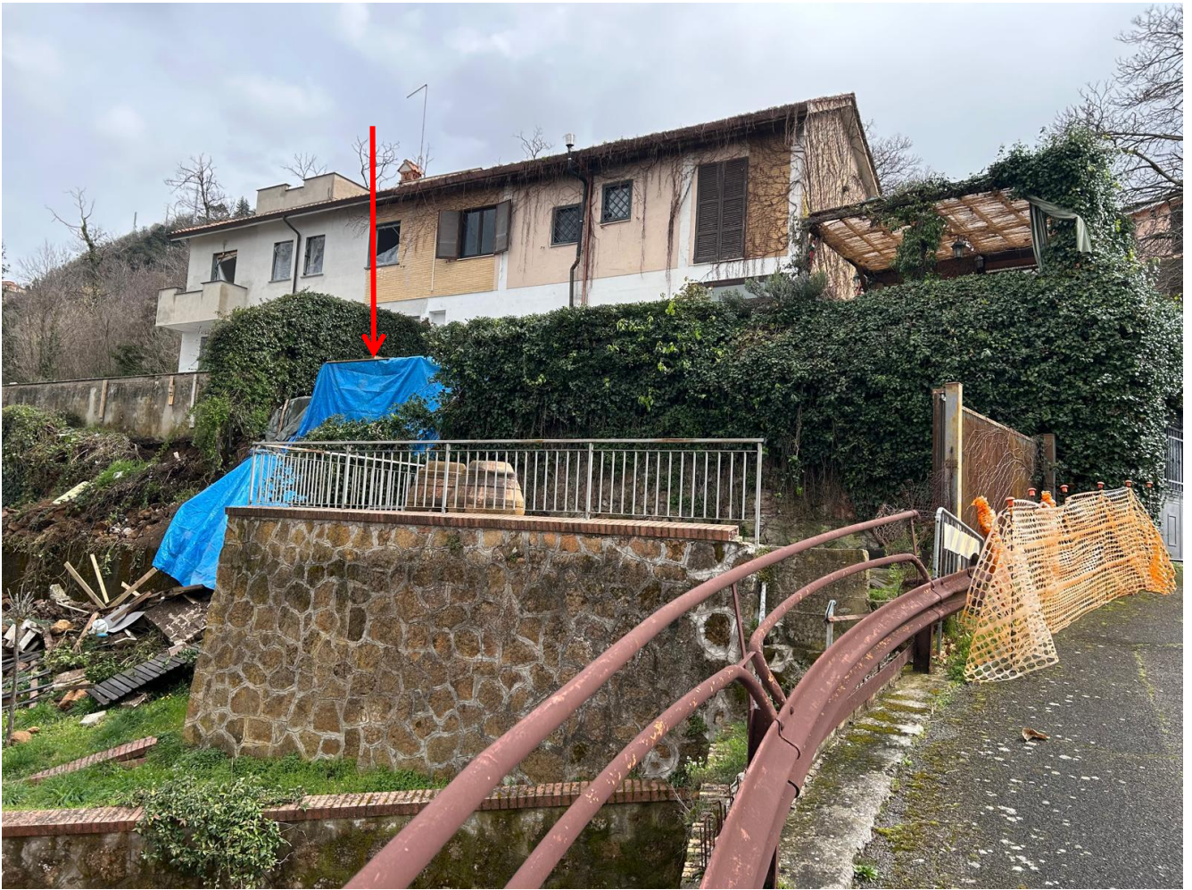
Fotografia scattata dopo il posizionamento del telo anti dilavamento
