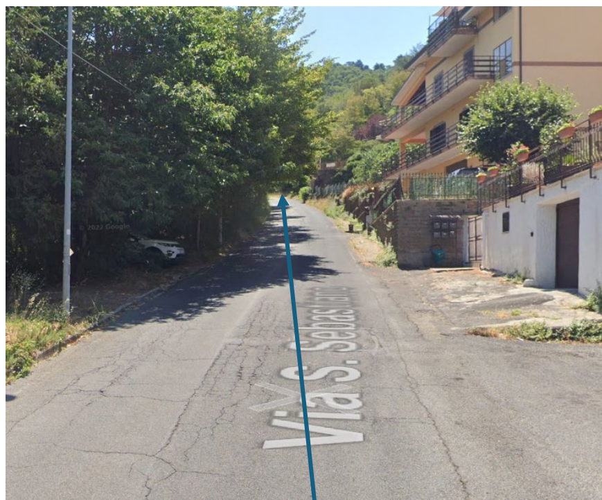
Cono di visuale 5 – Tratto di condotta su Via S. Sebastiano
