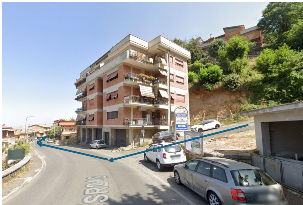
Cono di visuale 3 – Tratto di condotta in uscita dal centro idrico su Via Frascati
