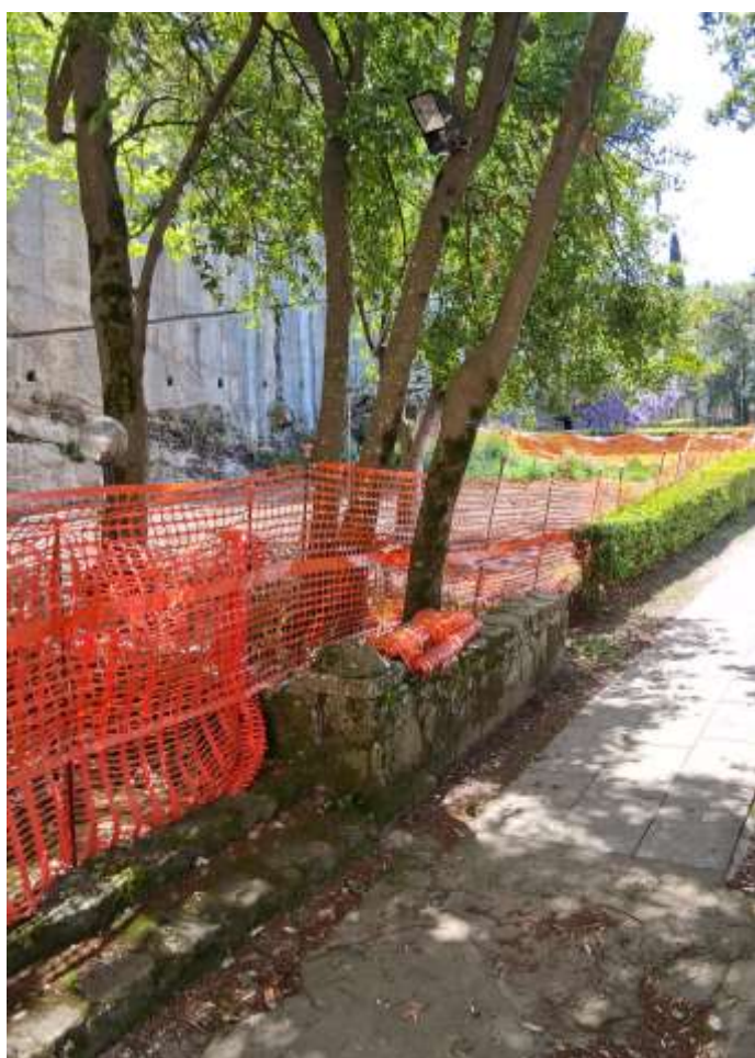
Foto 13 e 14: Vedute nella part. 32 di proprietà del Collegio di San Tommaso degli Inglesi, in cui si evince l'area ripulita dalle macerie, in seguito allo spostamento dei frammenti di peperino comunicato ai vari Enti in data 17 marzo 2025 tramite Pec, e avvenuto nei giorni 21 e 22 marzo 2025.
